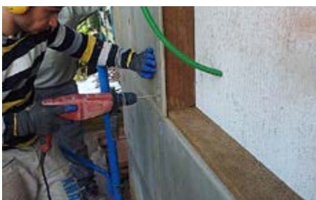
Realizzazione di angoli nel sistema per cappotto termico Betontherm fiber
