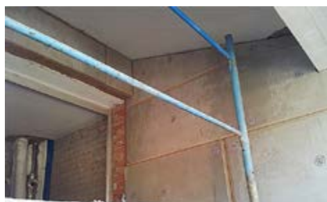
Realizzazione di angoli nel sistema per cappotto termico Betontherm fiber
